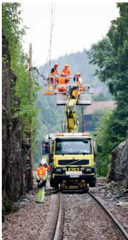
Kontaktledningsbygge i Minnesund i Norge med lifträlsbil.
